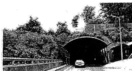
Écoduc au-dessus d'une autoroute
